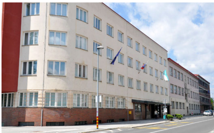
Prenova delavskega doma
