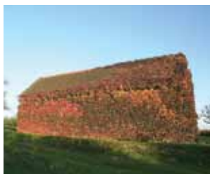
Sl. 9 Trirogljata vinika ( Parthenocissus tricuspidata ) v jesenski barvi, ki je preraščala fasado zahodne in severne stene gradu.
